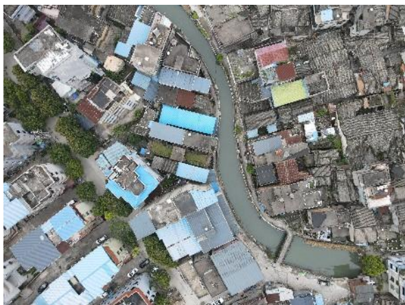
水体整治项目航拍
