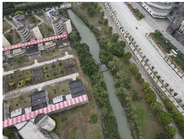
水体整治项目航拍
