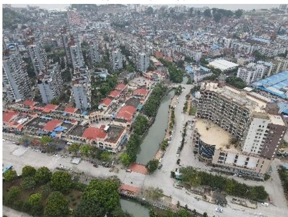
水体整治项目航拍
