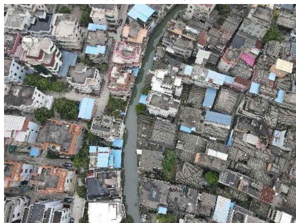
水体整治项目航拍
