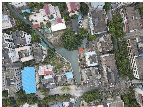
水体整治项目航拍
