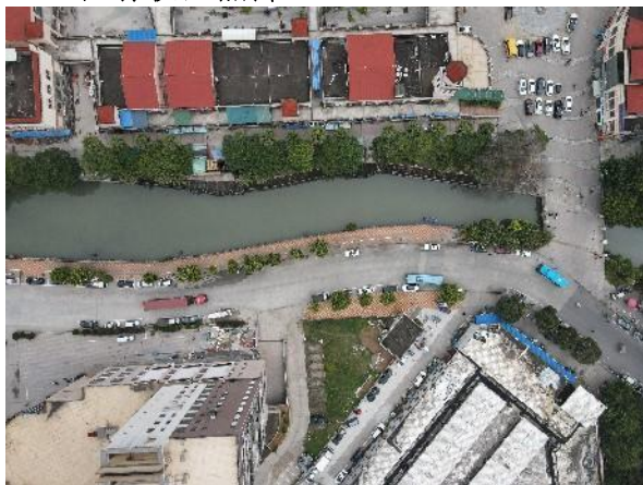
水体整治项目航拍
