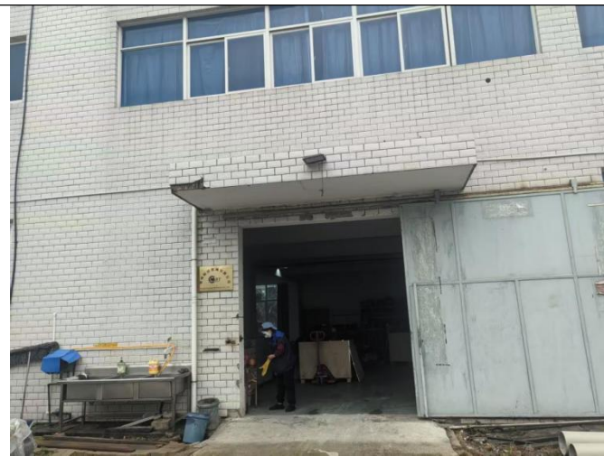
项目东南侧-福州坂田机械有限公司
