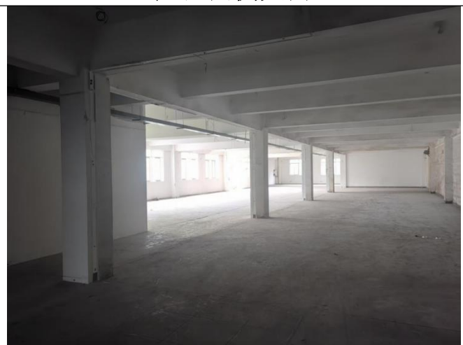
厂房二层现状（空置）
