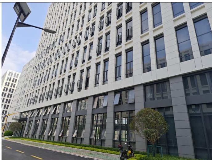
项目北侧为其他未装修施工厂房
