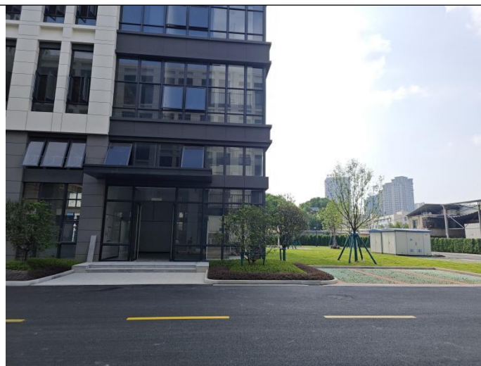
项目东侧为其他未装修施工厂房
