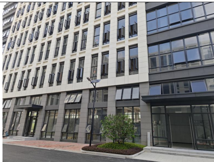
项目西侧为其他未装修施工厂房
