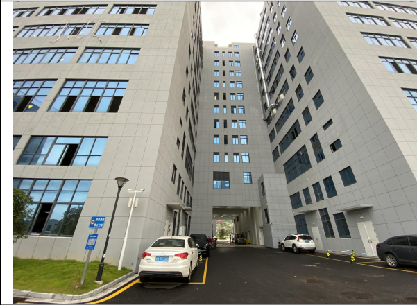
项目南侧厂房
