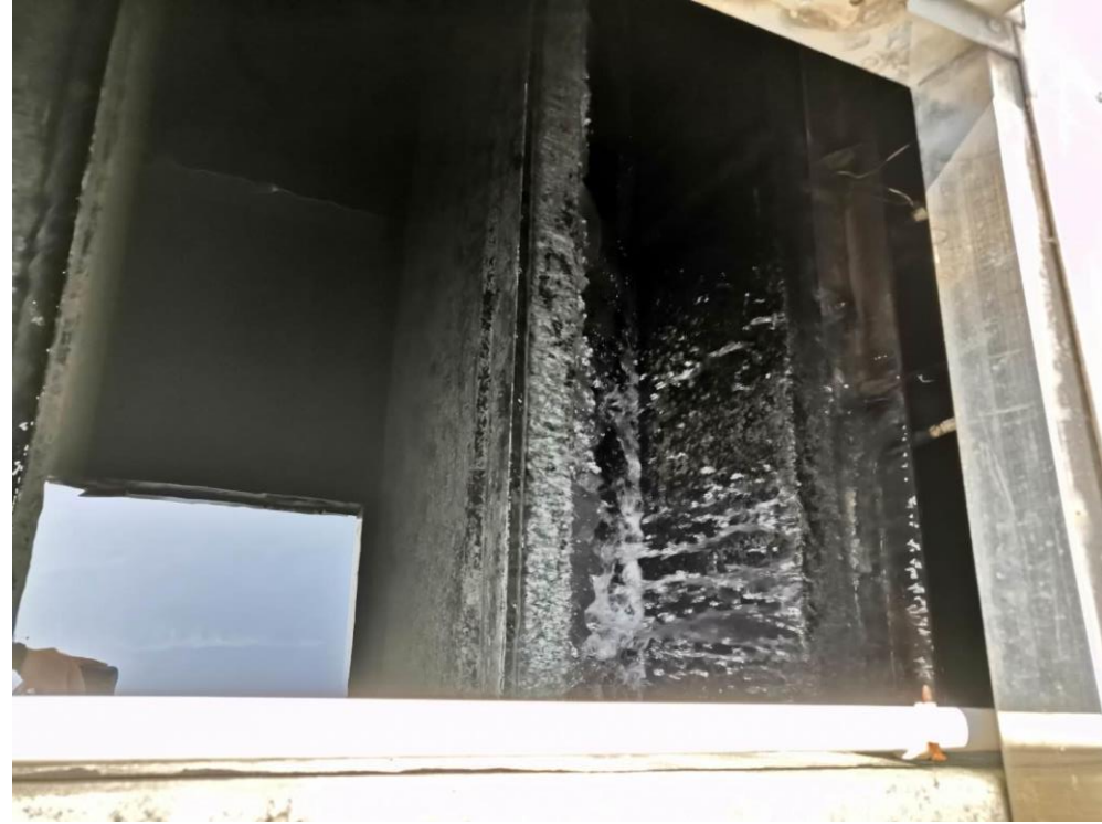
图4.1-8 长安污水处理厂出水情况
