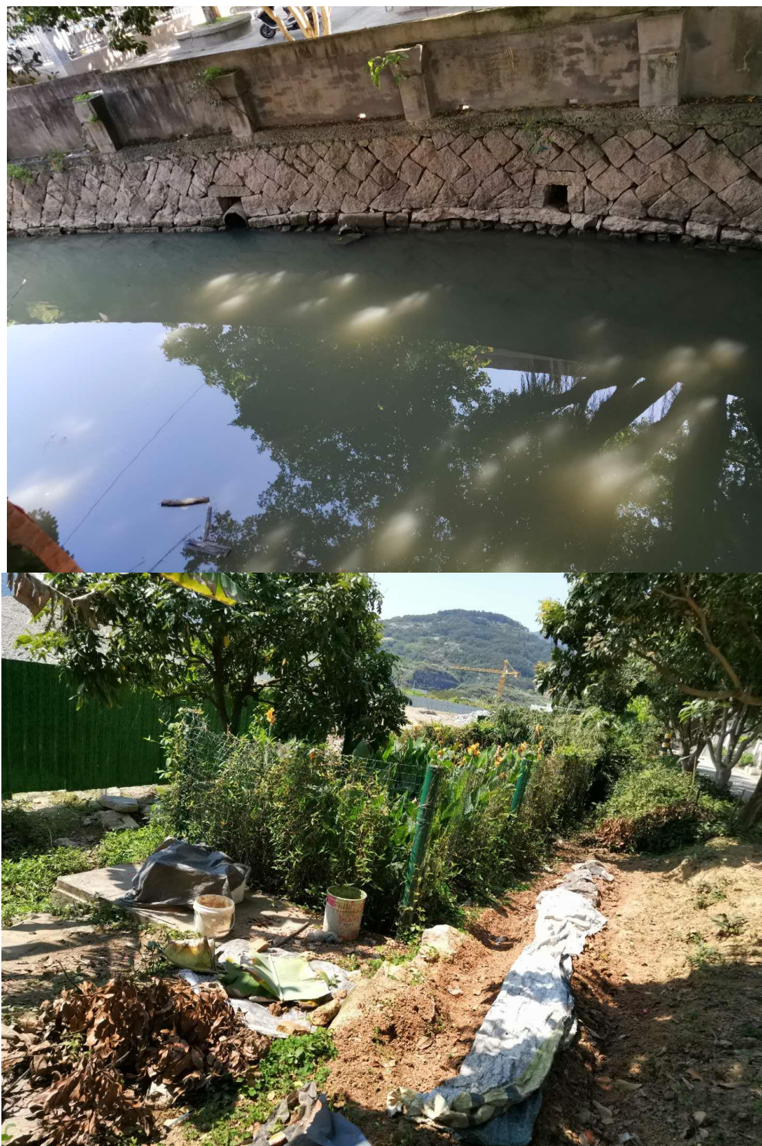
图4.1-10 亭江镇污水排放收集管网现状
