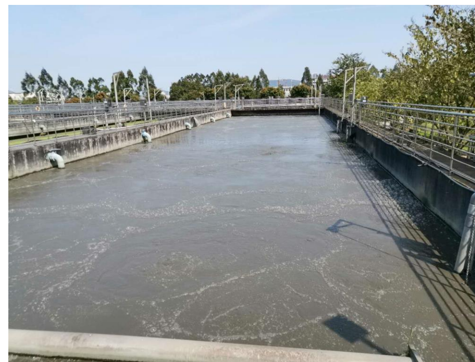
图4.1-7 长安污水处理厂现场情况
