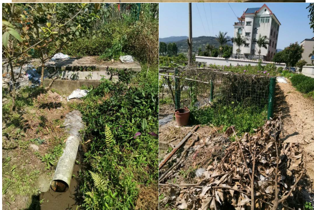
图4.1-12 鳌溪村污水处理设施现状
