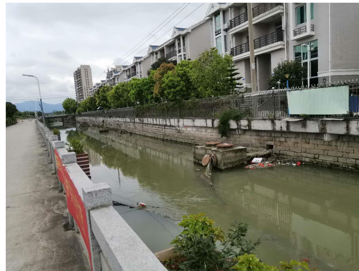
图4.1-4 琅岐镇污水排放收集管网现状
