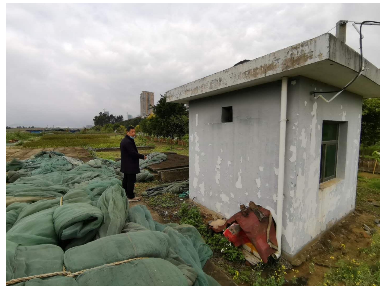
图4.1-11 闽江村污水处理设施现状
