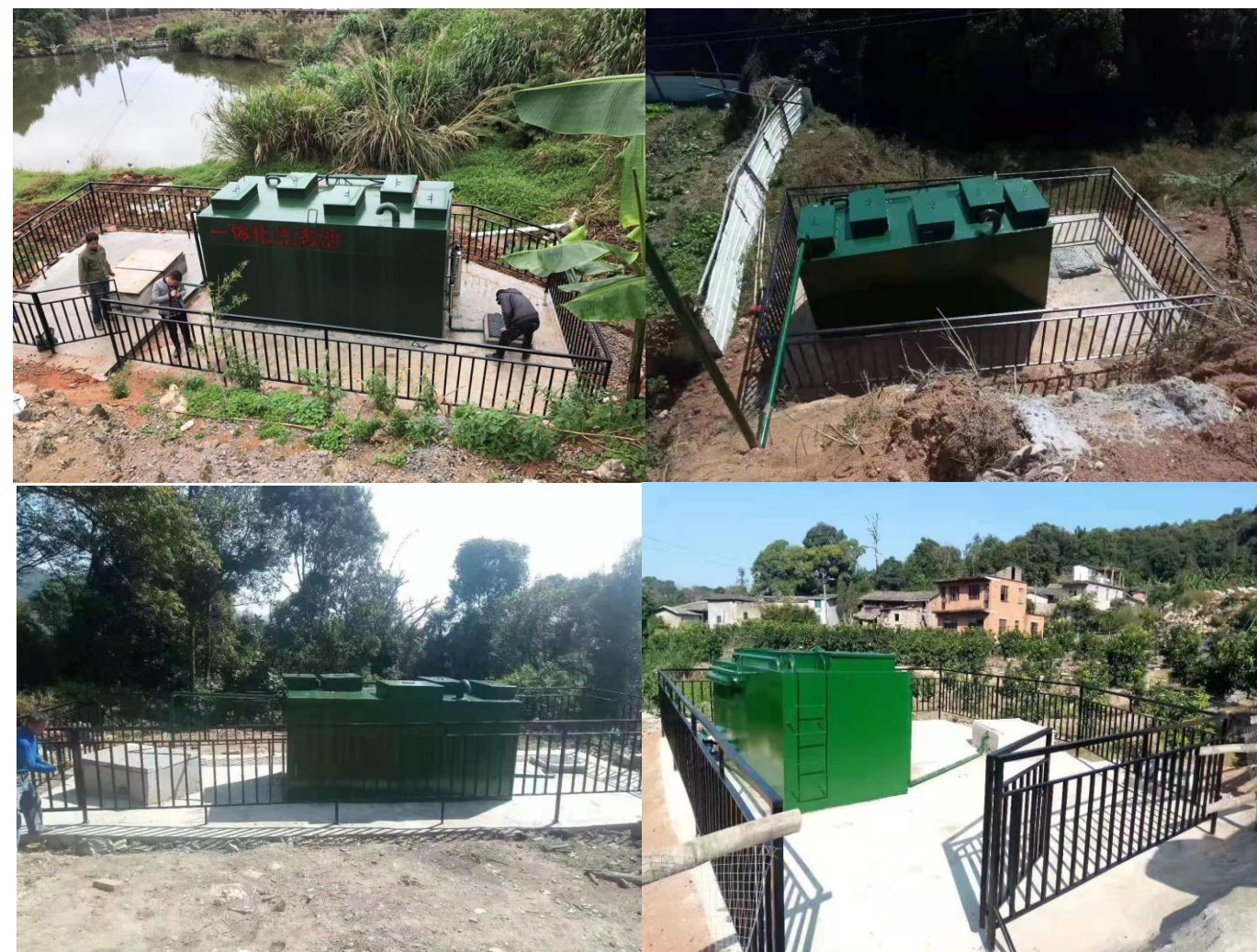
图4.1-15 牛项、上宅、下宅、凤洋自然村污水处理站
