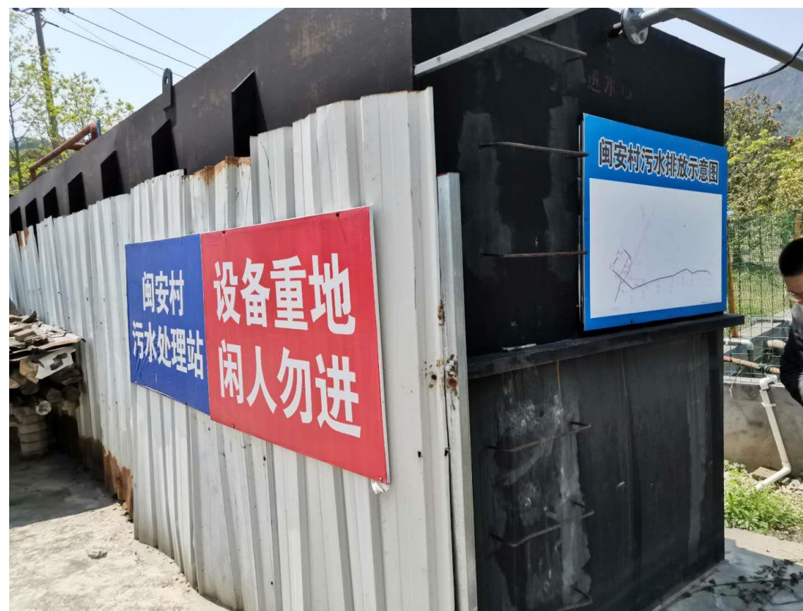
图4.1-13 闽安村污水处理设施现状
