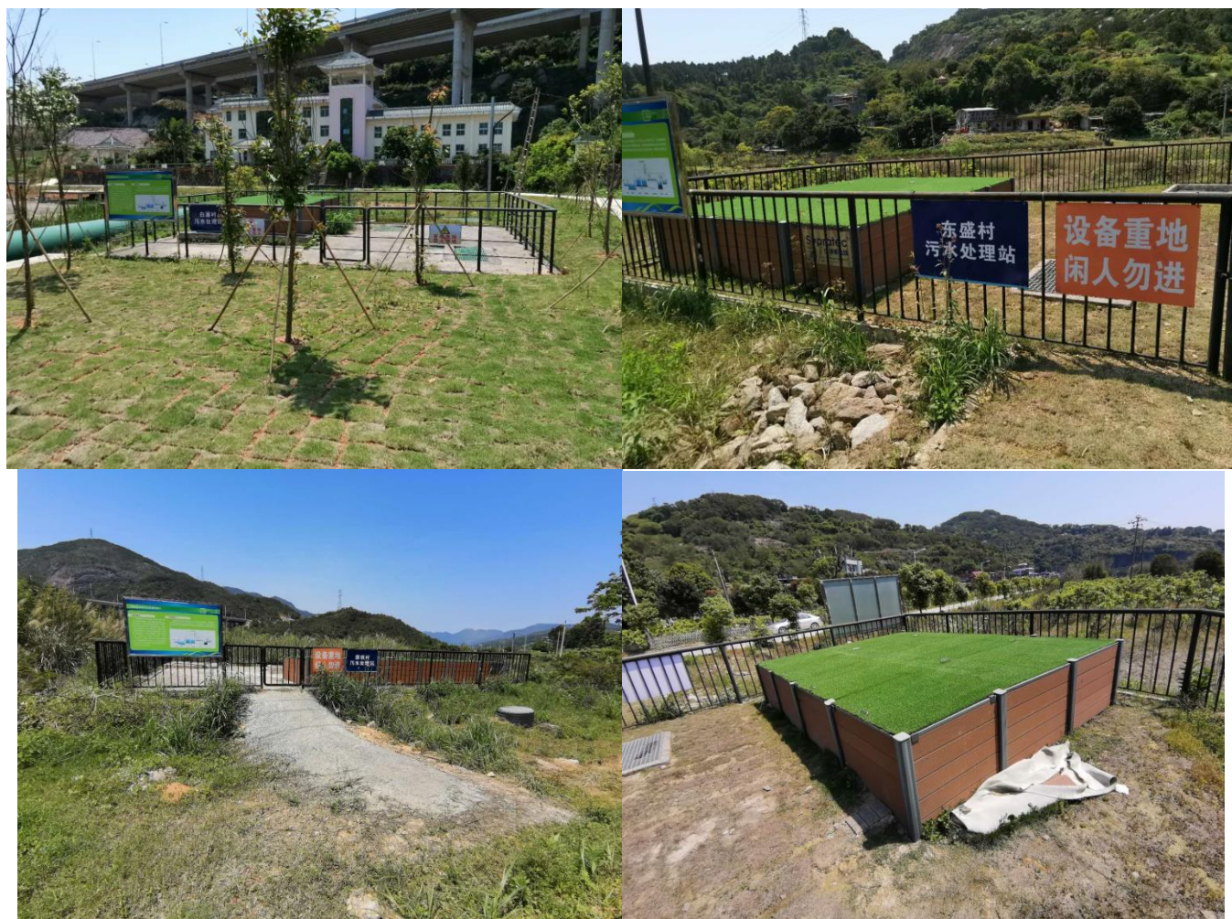
图4.1-14 东盛村、康坂村、前洋村、白眉村生活污水处理现状
